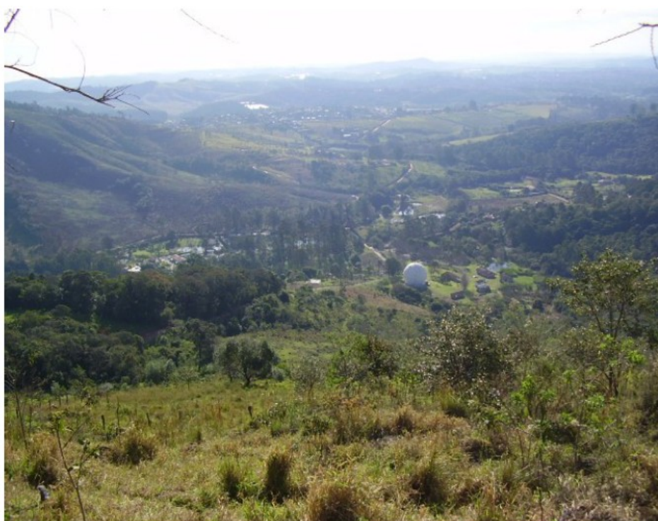
Figura 6.1 – Vista superior feita em um morro vizinho ao Rádio Observatório de Atibaia. No centro, encontra-se a redoma de 25 metros que encobre o radiotelescópio de 14 metros de diâmetro.
