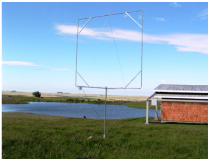
Figura 4.12: Vista panorâmica de parte do prédio 6 do Observatório Espacial do Sul – OES/CRS/CIE/INPE - MCT e de uma das antenas do tipo Loop, em São Martinho da Serra, RS.
