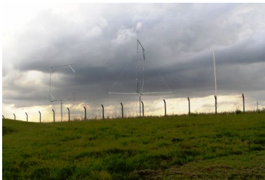
Figura 4.13: Vista panorâmica das antenas do tipo retangular I e II e da antena vertical do Sistema Rede SAVNET instaladas e em operação no Observatório Espacial do Sul, em São Martinho da Serra, RS.
