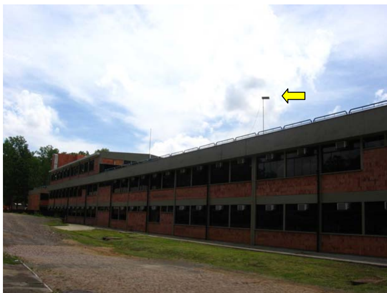
FIGURA 6.5 – Prédio Sede do Centro Regional Sul de Pesquisas Espaciais – CRSPE/INPE - MCT – localizado em Santa Maria - RS. Instalação provisória da Estação (S) do Sistema GPS.
