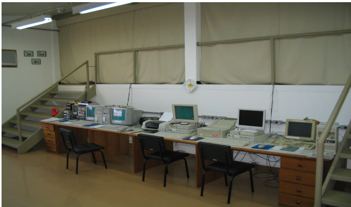
FIGURA 2-12: Central de controle instalado no Observatório Espacial do Sul – OES/CRSPE/INPE, no Prédio 5.
